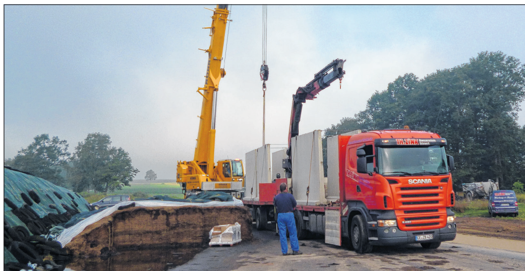
Die Firma Zink sorgt auch für fachgerechte Montage der Fahrsilo-Stellwände vor Ort.
