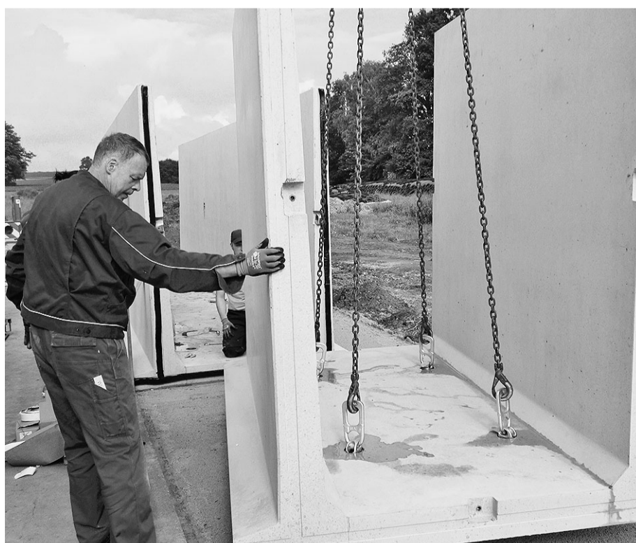
Insbesondere bei größeren landwirtschaftlichen Betrieben entstehen Fahrsilo-Anlagen mit nennenswerter Lagerkapazität. Foto: Zink
